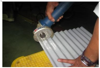
波板の切断 イメージ
